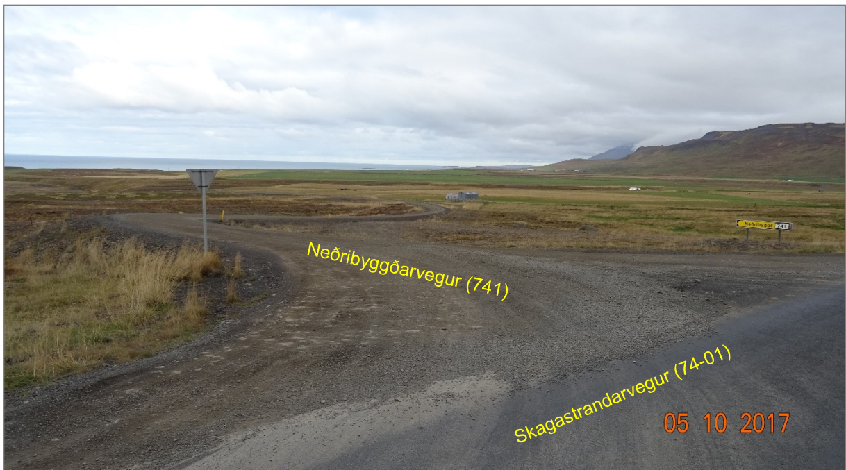
Mynd 11. Vegamót Neðribyggðarvegur (741) og Skagastrandarvegur hjá Neðri Lækjardal (ljósmynd: SJ).
